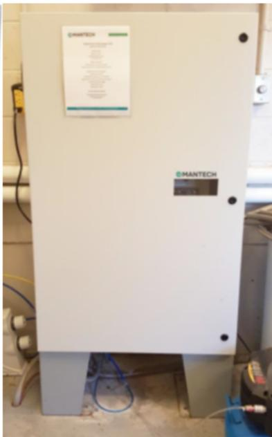
P100 PeCOD<sup>®</sup> 在线分析仪使用4-20 mA输出直接连接到监控和数据采集(SCADA)系统进行连续的在线监测，因此结果可以在控制室内进行监测。现在的设备仅允许分析一个样本流。通过样品管(设备柜的底部左边)的样品流速要求大于35 L/min，自来水流速大于2 L/min，压缩空气压力大于600 kPa。样品管使用50  $\mu$ m金属过滤网，并且每半小时进行反冲洗。设备柜可以固定在墙上或地板上。
